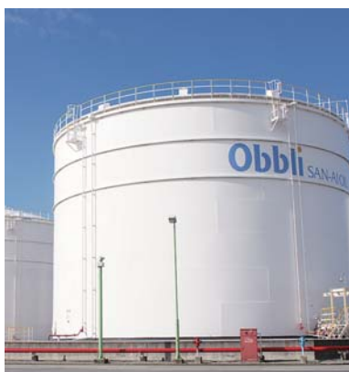
2016年4月より羽田空港において貯油タンク2基の増設工事を進めています。2020年1月供用開始予定です。
